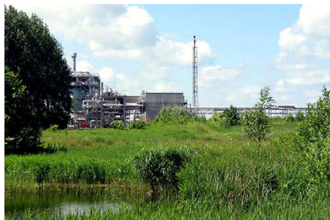
De gasopslagplaats ligt in het Groningse Grijpskerk.
